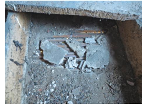
**Stato della "caldana" (l'intonaco al di sopra del soffitto), prima dell'intervento...**
