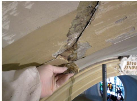
gressivamente staccando l'intonaco del soffitto, con il rischio di cadere e provocare seri danni. Occorreva agire quindi con urgenza e determinazione per evitare soprattutto pericoli all'incolumità delle persone. Alcune analisi, inoltre, mettevano in luce che vi erano numerose fessurazioni che non apparivano ad occhio nudo
